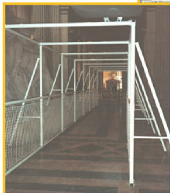
Tunnel blindé au Panthéon à Paris.
