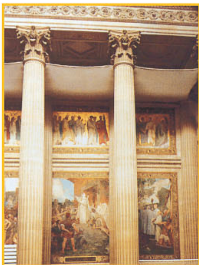
Filet de protection et garde-corps métallique au Panthéon à Paris.
